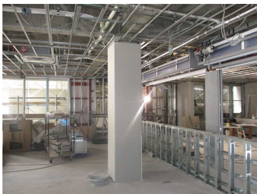
内装の工事も進んでいます。
